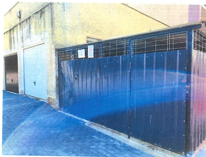
Zdjęcie nr 9. Wiata śmietnikowa przy ul. Wysockiego 10
