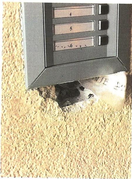
Zdjęcie nr 4. Klatka schodowa bloku nr 8 przy ul. Wysockiego.
