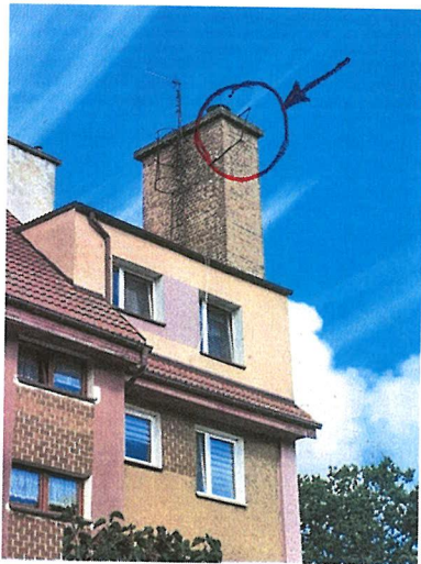
Zdjęcie nr 1. Komin bloku nr 8 przy ul. Wysockiego.
